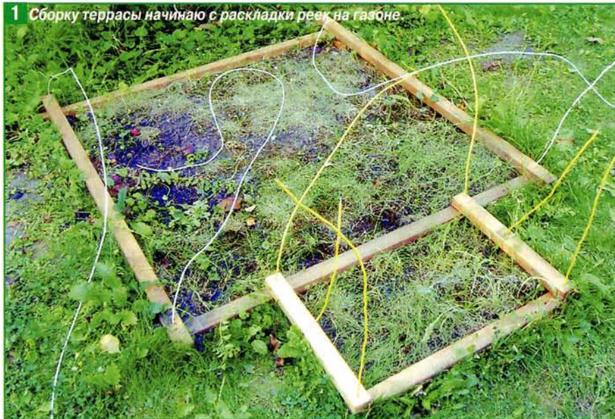
1 Сборку террасы начинаю с раскладки реек на газоне.
